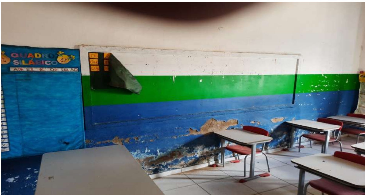
Escola Municipal Luiz Epaminondas Filho - infiltrações na parede.
