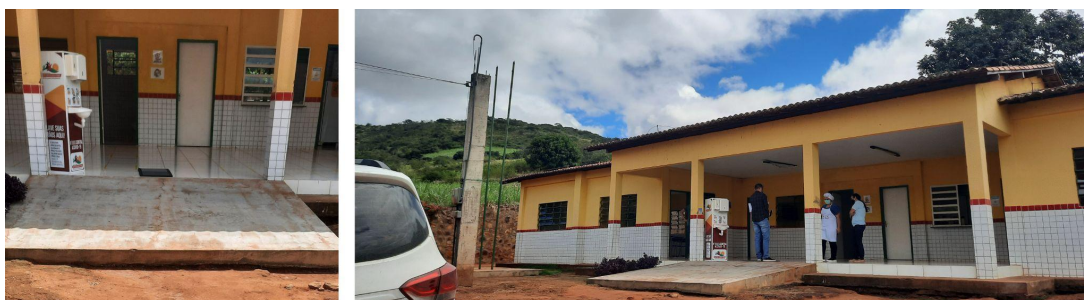
Figura 1: Rampa de acesso à escola João Bosco Rodrigues de Souza.
